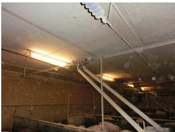
Foto van het IC-ionIC systeem. Drie coronalijnen met naaldvormige elektroden in proefafdeling
