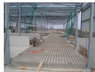
Een dichte vloer biedt mogelijkheden om dagverse mest af te voeren.
