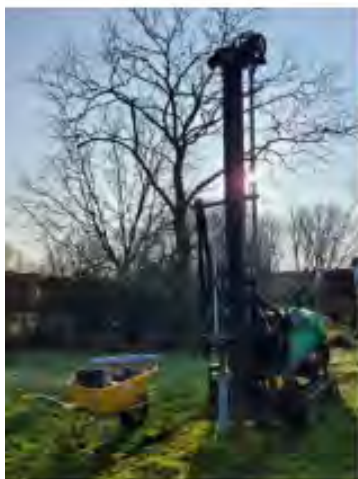
Foto 5: Start bouw biobased vergader paviljoen.
