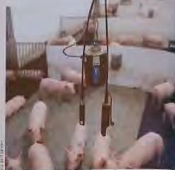
Met sensoren zoals deze in een varkensstal, kan je bij een doelvoorschriftvergunning aantonen dat je onder je emissieplafond blijft.
