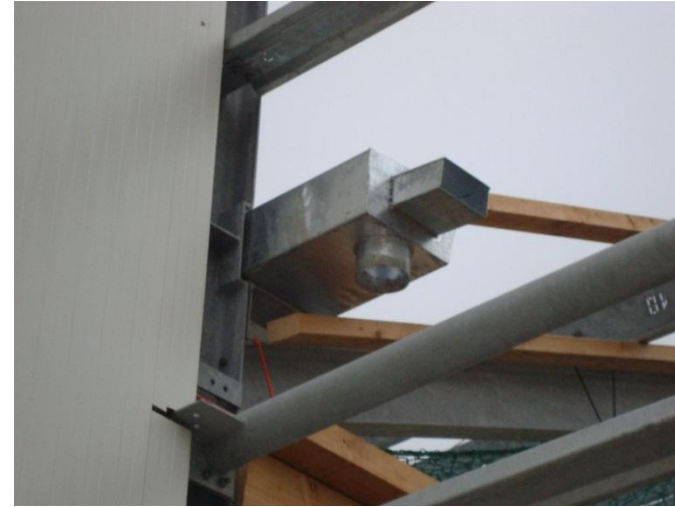
12. Nood-uitloop in dakgoot is een must
