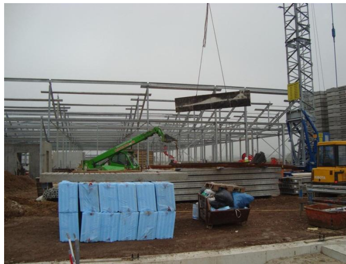
2. Bouw in volle gang
