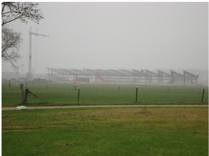
3. Bovenbouw stal in aanbouw
