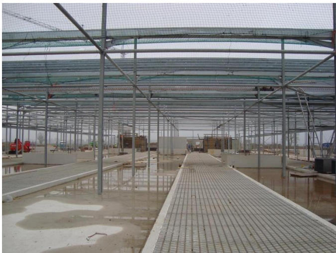
7. Prefab vloer op gestorte strokenfundering
