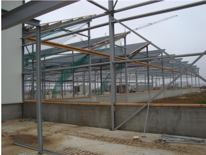
11. Afstandfoto van de stal in aanbouw
